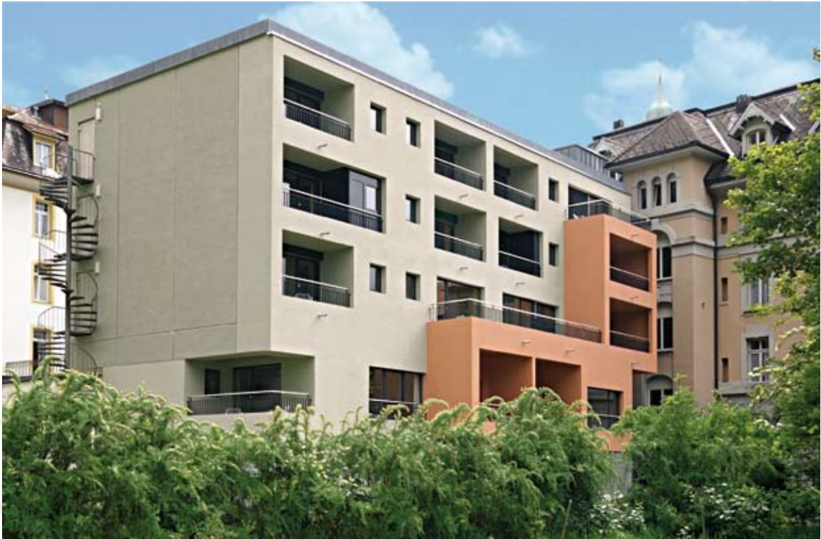
Aussenansicht des renovierten Anbaus
